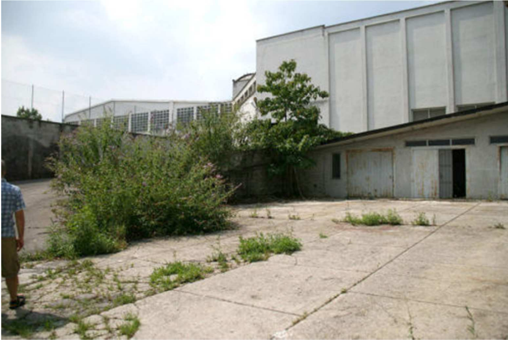
L'area di scarico dei lattonzi
